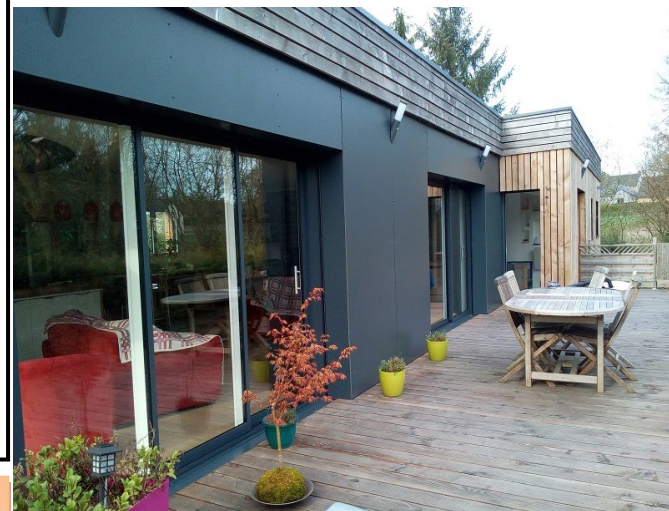
Bardage extérieur pour cette maison de plain pied : partie mélèze de Sibérie et partie Trespa.
